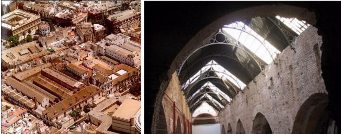
Vista aérea Reales Atarazanas (IAPH) y vista de las cubiertas desde el interior de una nave.
