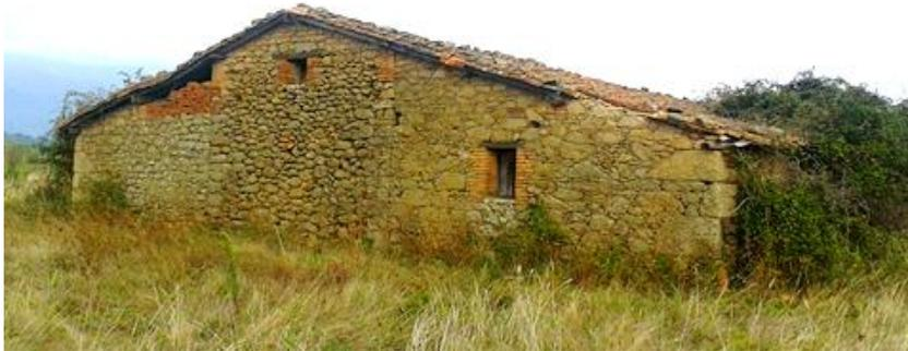
Así nos encontramos ante edificios readaptados: primeras construcciones de piedra, piedra y adobe, ladrillo macizo, con sus característicos cerramientos formando celosía, huecos de ventilación para el secado.
