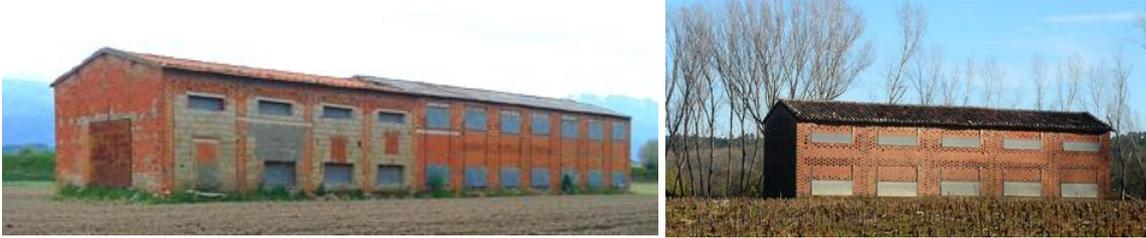
Los secaderos son una construcción longitudinal, tejado a dos aguas, modular (principalmente con múltiplos de 3 metros), de una, dos y hasta tres alturas; con muy diversas técnicas de construcción, diversos volúmenes, y variados cromatismos, formando conjuntos de edificios o aislados, siempre buscando la finalidad práctica y económica de su uso, aunando el buen oficio de los constructores, sin menoscabo en algunos casos a la estética...
