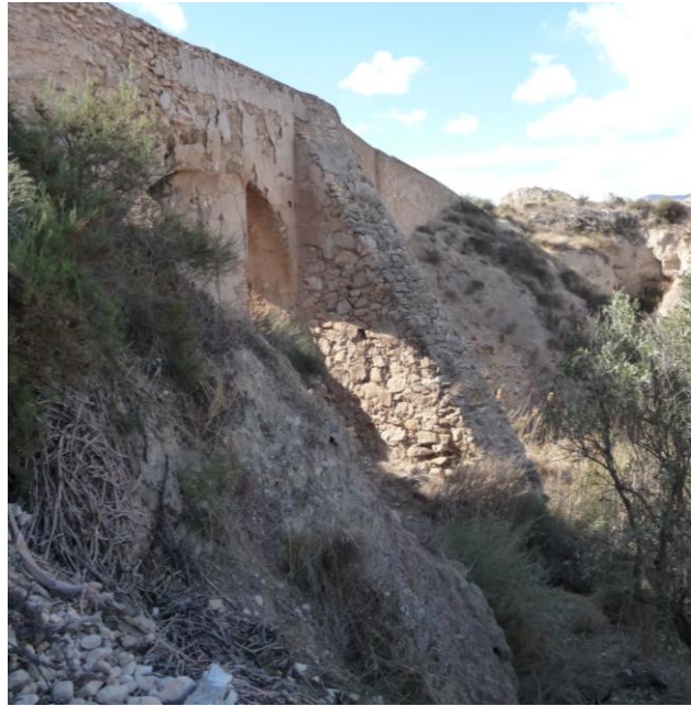
Episodios de riadas como la ocurrida en Alicante del 20 de octubre de 1982 explican la potencia del contrafuerte del acueducto en el barranco de las Ovejas.
