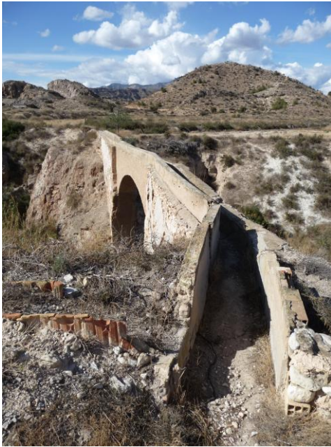
Episodios de riadas como la ocurrida en Alicante del 20 de octubre de 1982 explican la potencia del contrafuerte del acueducto en el barranco de las Ovejas.
