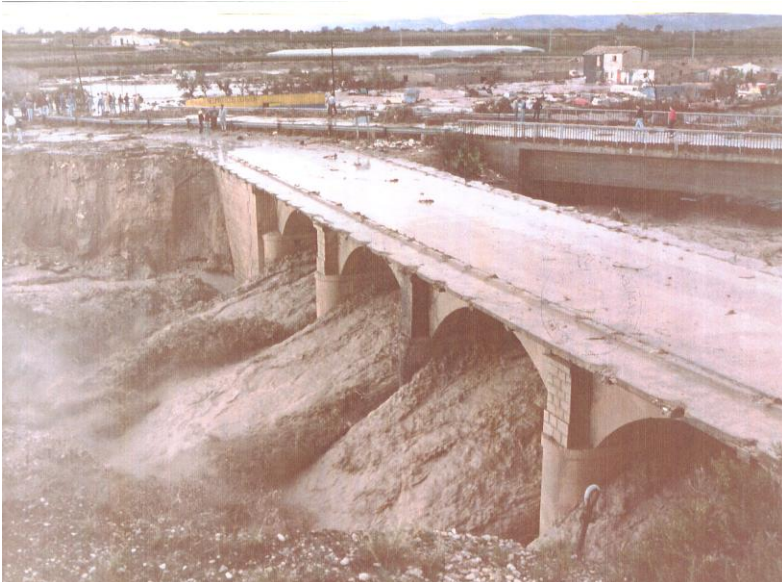
Riada de la madrugada del 4 de noviembre de 1987. El río Seco arrasó el puente del tren y la vía quedó colgando.
