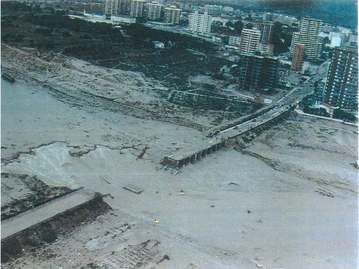
Riada de la madrugada del 4 de noviembre de 1987. El río Seco arrasó el puente de la carretera de la playa.
